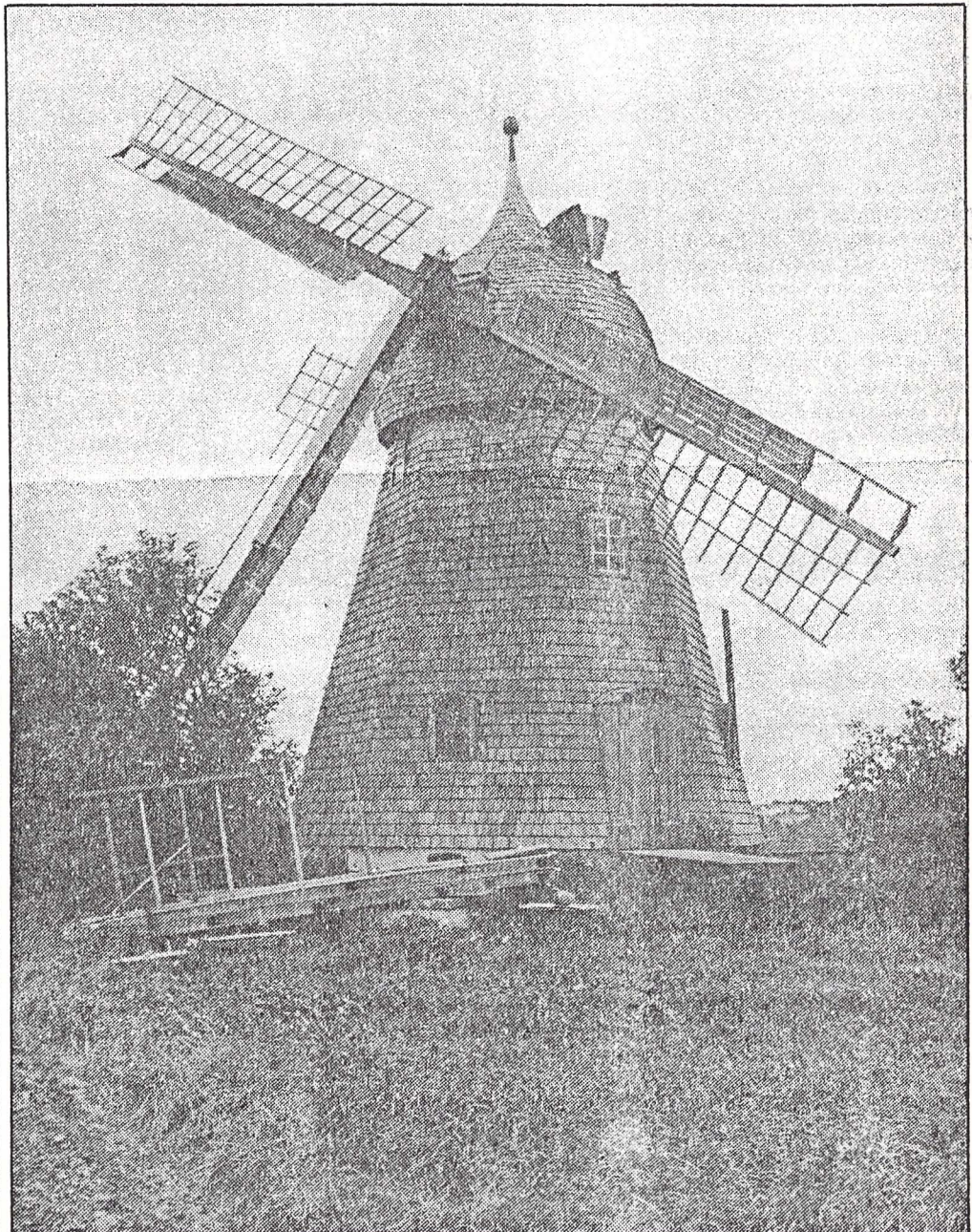
Stenvad Mølle, som der ser ud i dag. Som det ses, er den ene vinge faldet af, og krøjvingerne er i en elendig forfatning.
