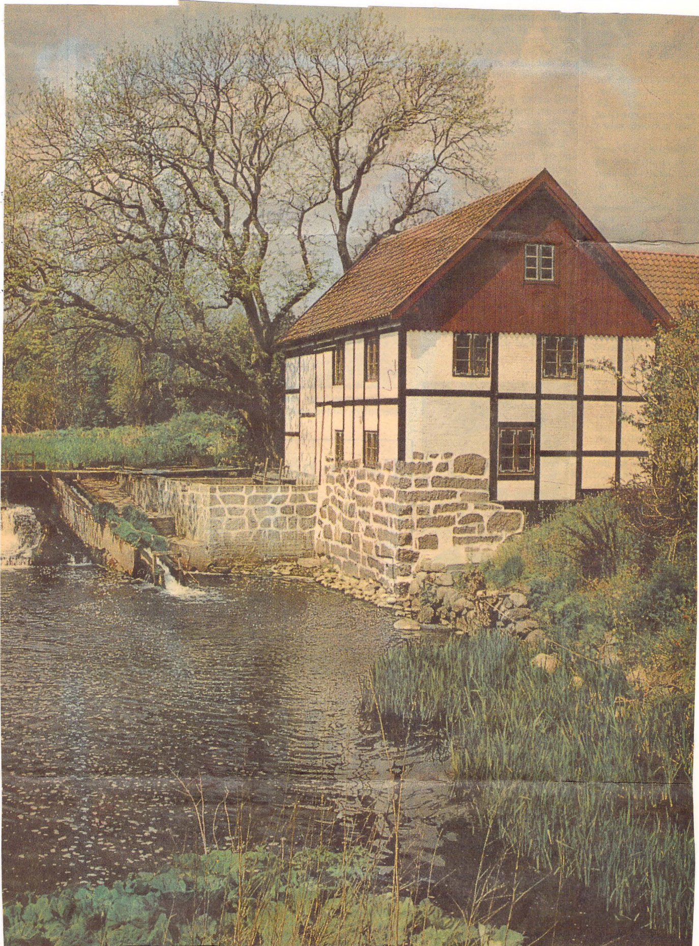
Smukt tager den sig ud den nyrenoverede vandmølle i Sæby. Kampestens-hjørnet kan dateres tilbage til år 1640. Ved siden af laksetrappen står soklen til det kommende turbinehus.
