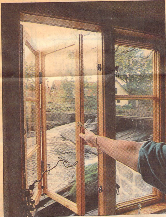
Vinduet med koblere rammer er udført efter tegninger fra Planstyrelsen. Det tog en hel vinter at fremstille alle vinduer til møllehuset.
