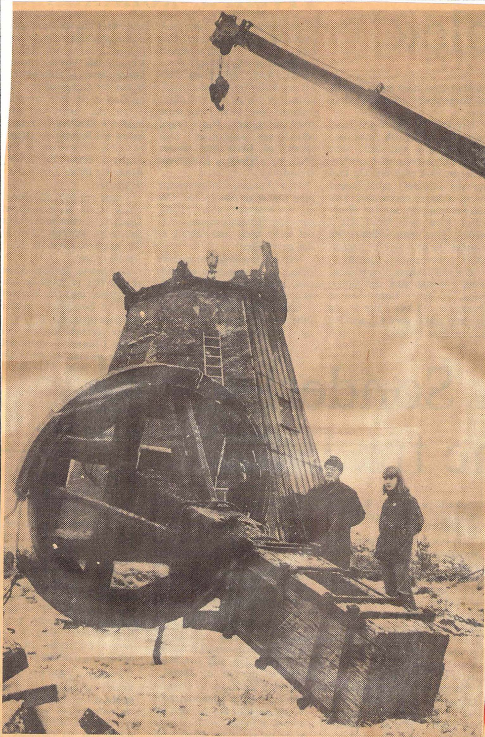
Højrup Mølle har mistet sin hat, og desuden er aksel og tandhjul blevet afmonteret og vil indtil videre blive opbevaret på Asdalgård. (Foto: Axel Søgaard).
